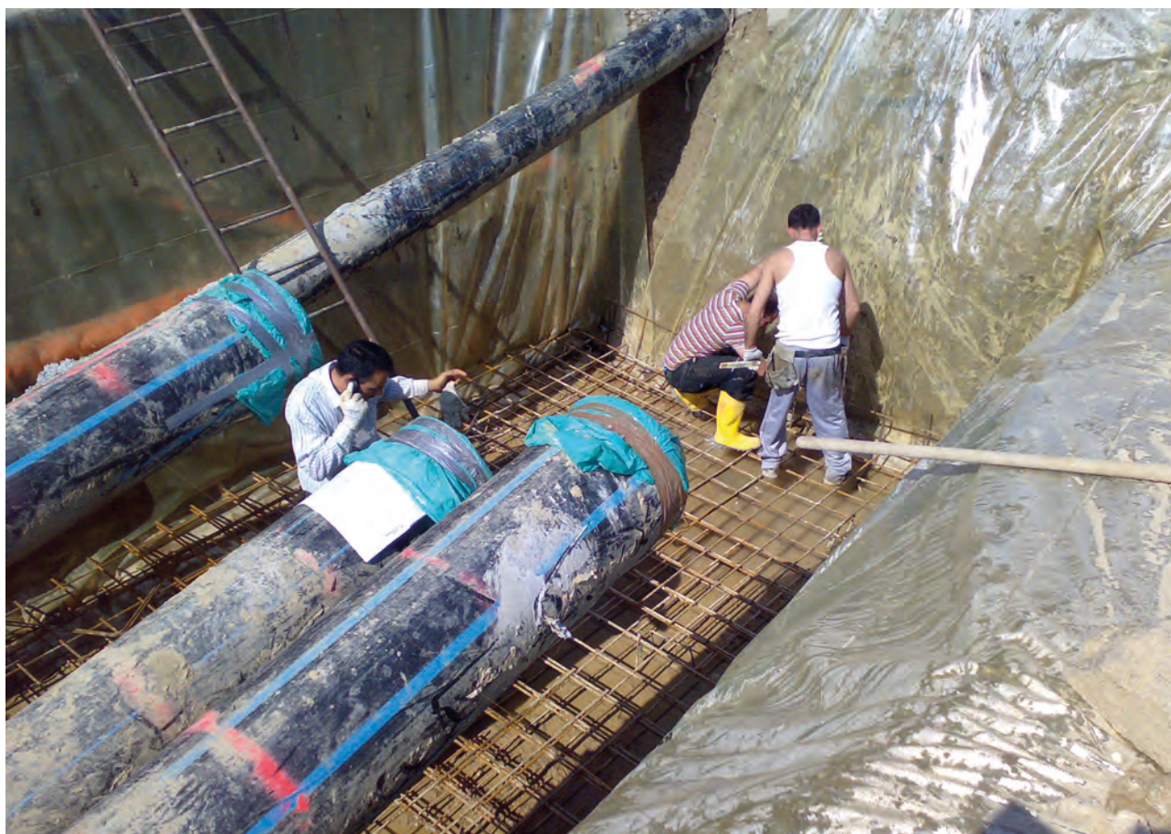
Lavori di muratura per la realizzazione dei locali tecnici. All'interno dei tubi guaina posati verranno "infilate" le tratte continue di CASAFLEX
