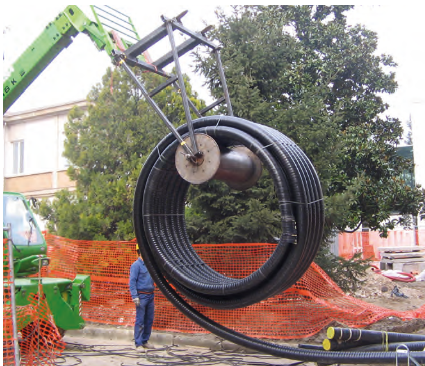
Stesura del tubo flessibile in tratta unica
