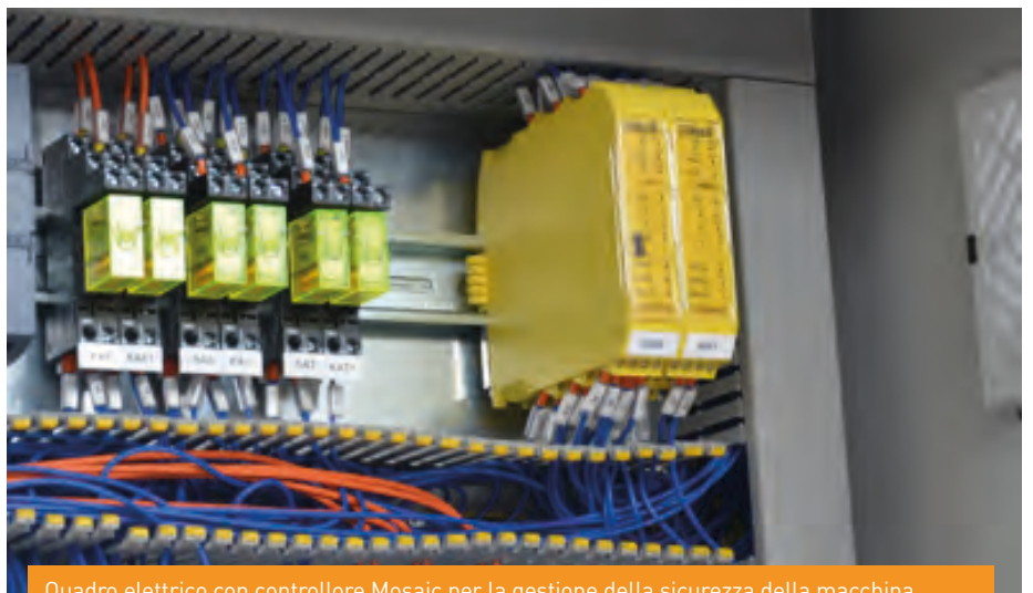
Quadro elettrico con controllore Mosaic per la gestione della sicurezza della macchina Per la realizzazione del sistema di protezione e sicurezza bordo macchina vengono utilizzati:
