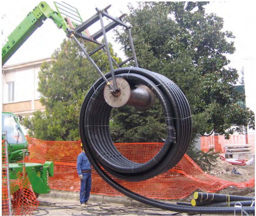
Stesura del tubo flessibile in tratta unica
