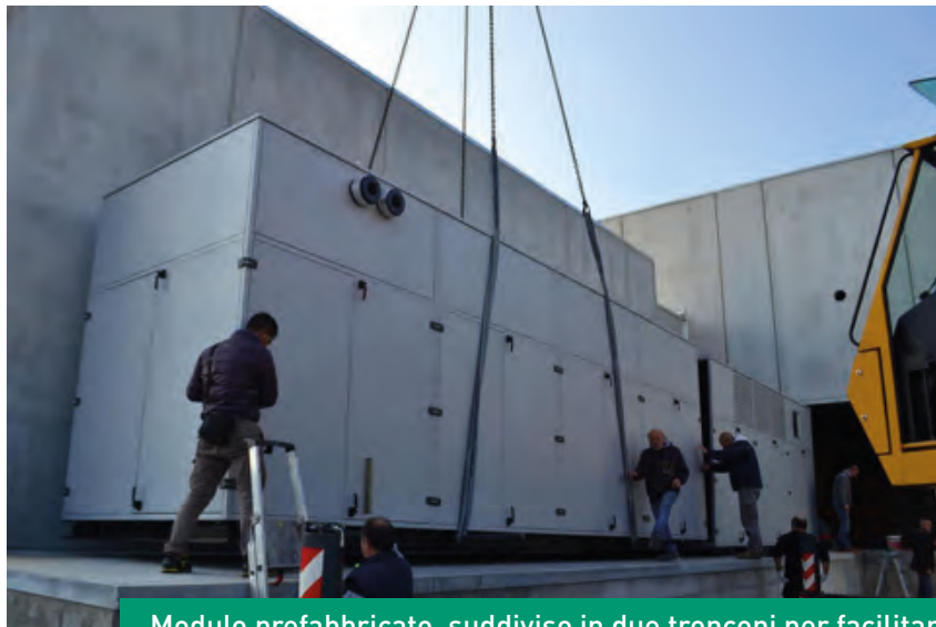
Modulo prefabbricato, suddiviso in due tronconi per facilitare trasporto e posizionamento
