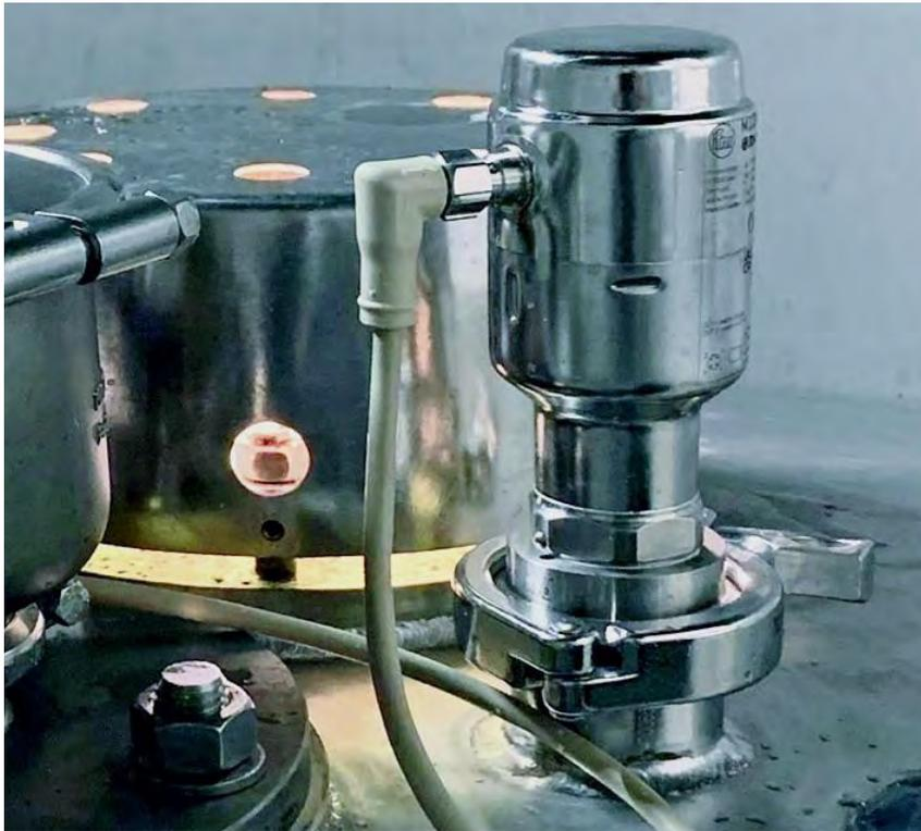
Il sensore è installato sulla parte superiore del serbatoio e misura la distanza dalla superficie del fluido tramite il segnale riflesso
