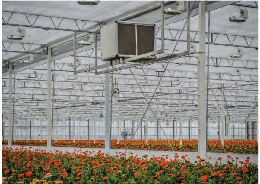
nerare una nebbia di particelle d'acqua ultra-fine che, evaporando rapidamente, creano un raffreddamento efficace. Questo sistema è ideale per ambienti agricoli come le serre, dove la temperatura deve essere mantenuta a livelli ottimali per la crescita delle piante. Inoltre, la nebulizzazione aiuta anche a migliorare la qualità
