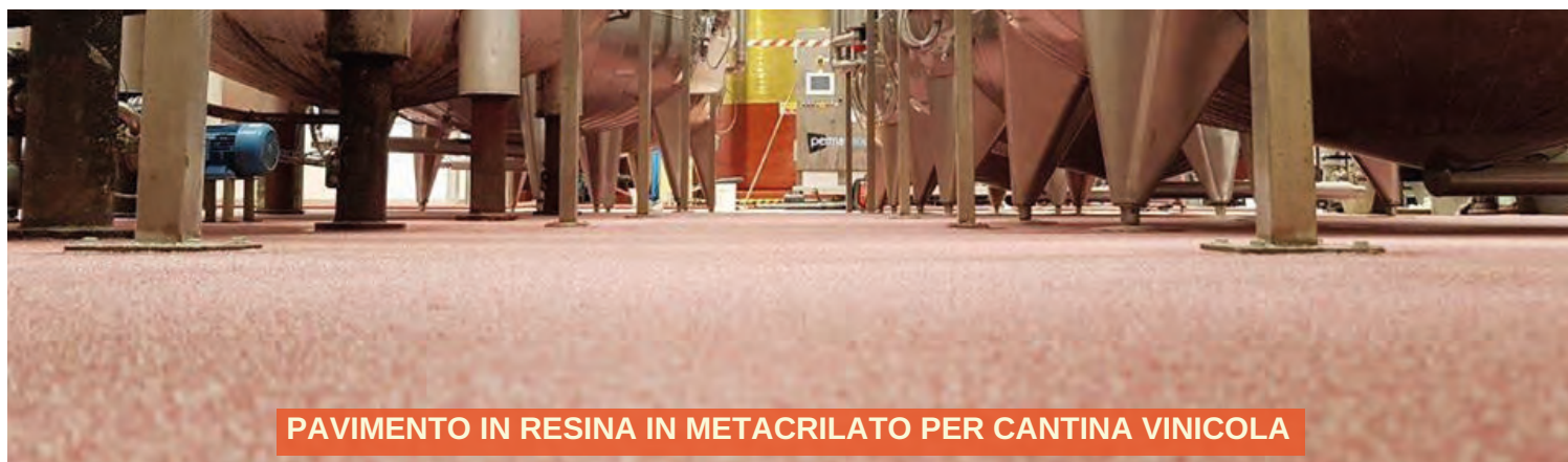
PAVIMENTO IN RESINA ANTIACIDO PER CANTINA VINICOLA
